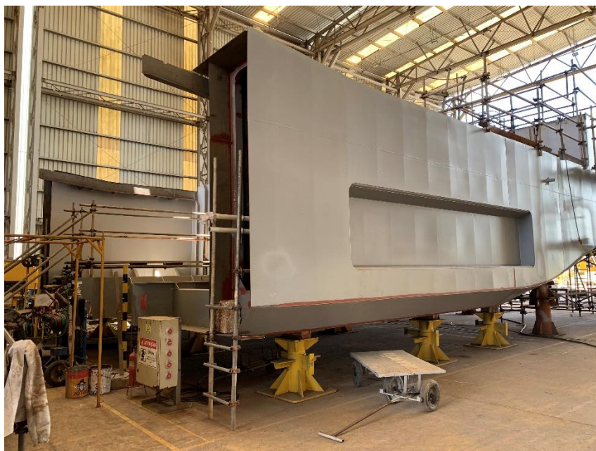
Empurrador elétrico HB Enguia em construção, em Salvador.
